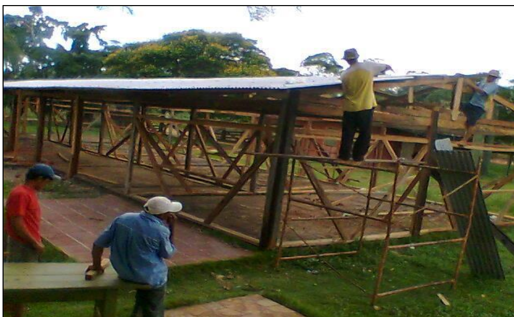
Figura 7 - Mutirão de construção da E. E. Florestan Fernandes
