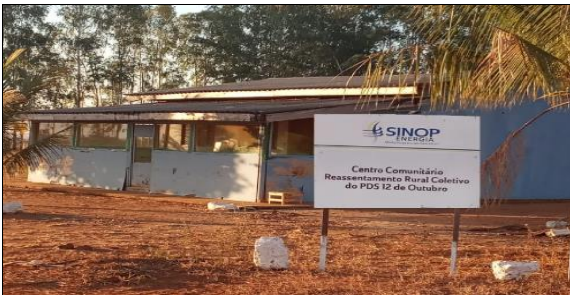
Figura 19 - Centro Comunitário do Reassentamento.
